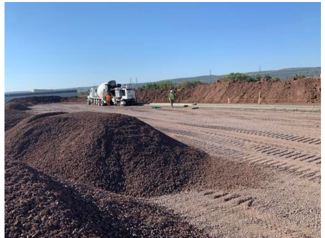
Pouring Trailer Curb & Gravel Import
