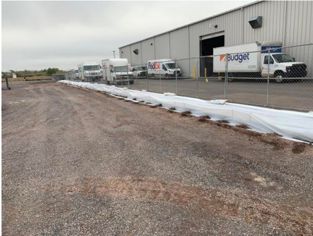
Valley curb pour
