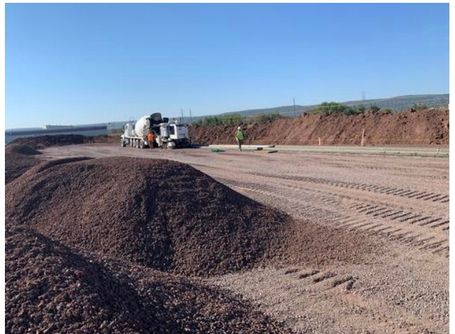
Pouring Trailer Curb & Gravel Import
