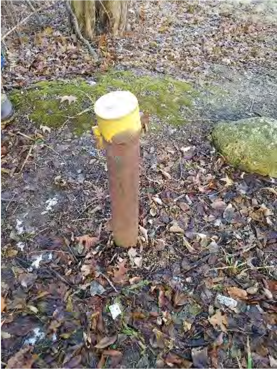
145. B-96-18A, looking NE
