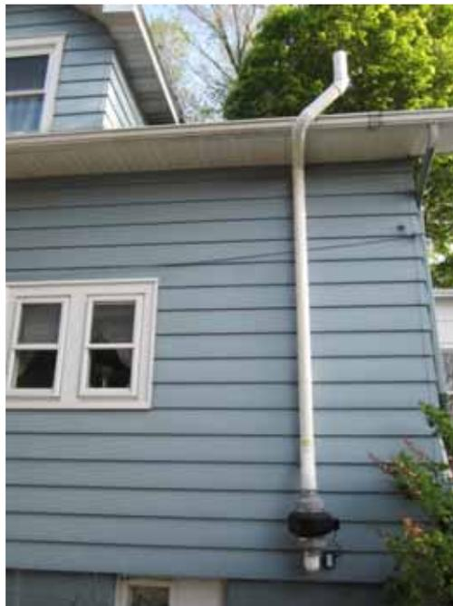
Basement SSDS fan and discharge piping
