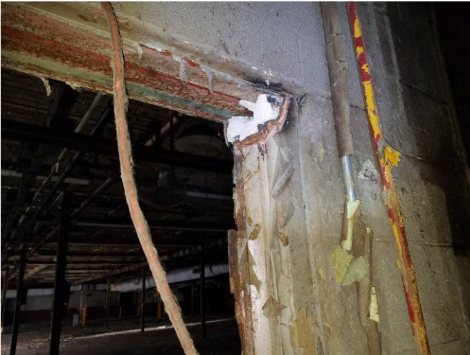
Photo 20) Gray Door Caulk – Bldg 12 West Room
