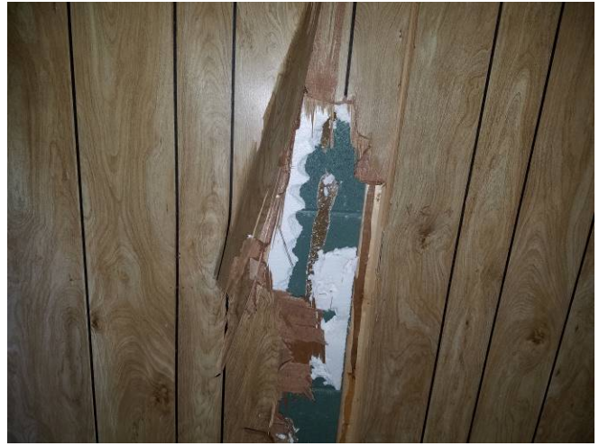
Photo 17) Brown Paneling Adhesive – Bldg 11
