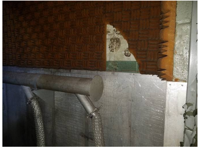
Photo 16) Brown Wall Adhesive – Bldg 12
