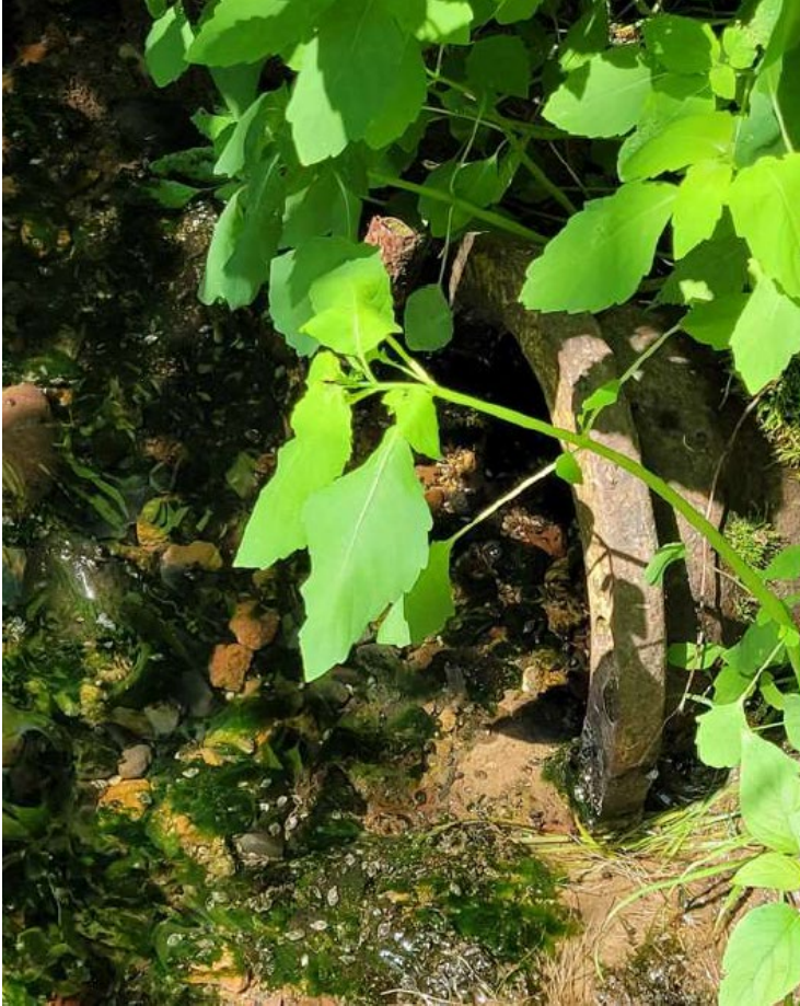
Photo 1 (Ryzak, 6-2023). Effluent outfall.
